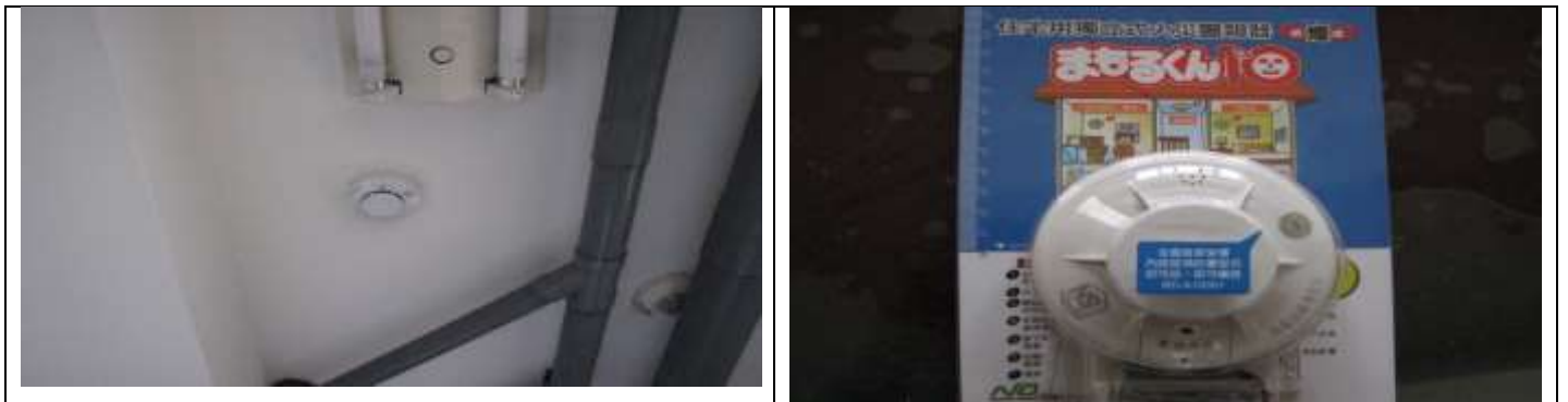
5月23日：大社區大吉路20號缺失複檢改進情形(火警警報器故障，改裝獨立型獨立型偵煙偵測器)
